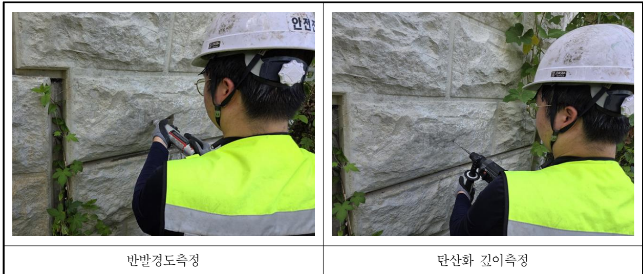
【사진 8.4.1】 재료시험 조사 전경
