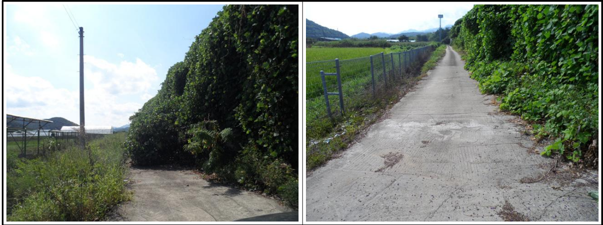
【사진 8.3.1】 지반, 기초부 전경
